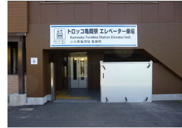
エレベーター整備
