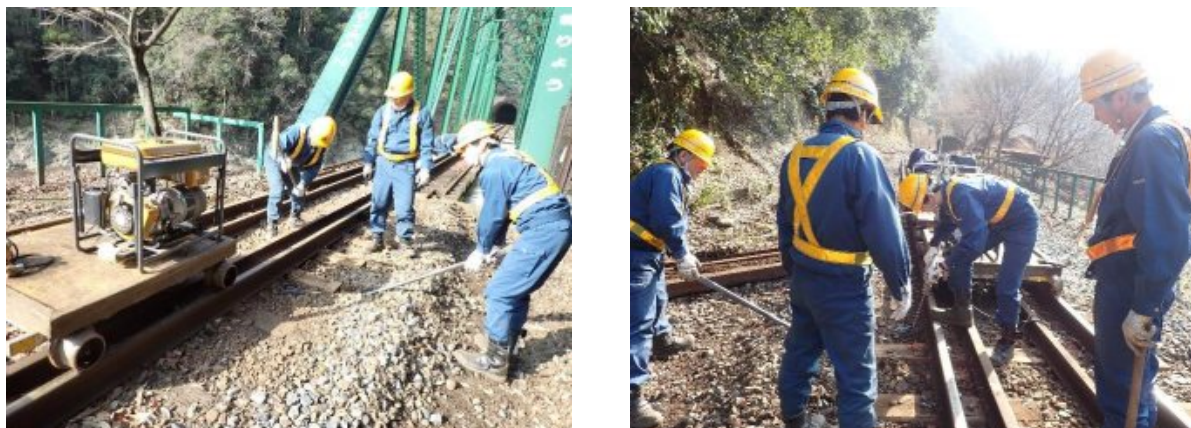
【技術継承を目的とした直轄作業によるマクラギ交換作業】
