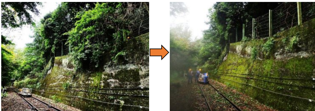
【擁壁から伸びた枝を伐採】
