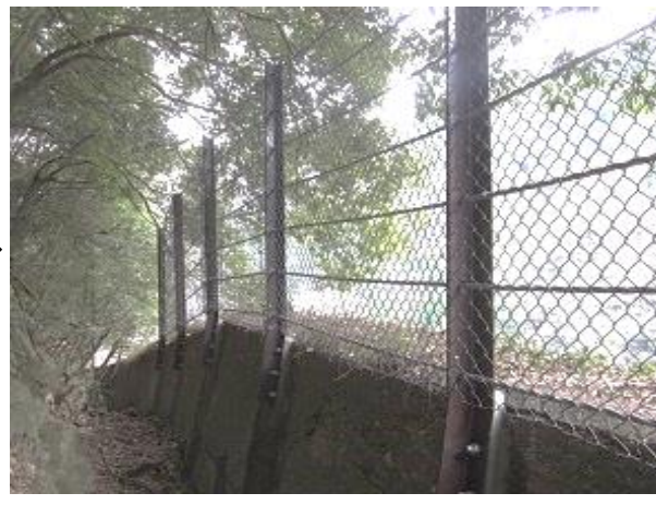
【トロッコ嵐山・トロッコ保津峡駅間】
